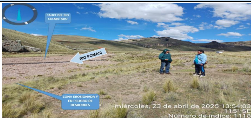
FIGURA 1 y 2 : TRAMO CRÍTICO EN EL RÍO POMASI, EN EL SECTOR PALCA, DISTRITO DE PALCA, PROVINCIA DE LAMPA - PUNO. NOTESE, LA ACUMULACION DE MATERIAL SEDIMENTADO EN EL CAUCE, QUE REQUIERE SER ELIMINADO PARA REESTABLECER LA SECCION HIDRAULICA DE LA CAJA DEL CAUCE EN ESTE SECTOR.
